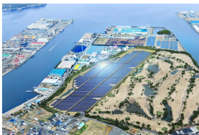
※香川県三豊市 太陽光発電所
